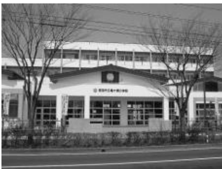
亀ヶ崎小学校正面
